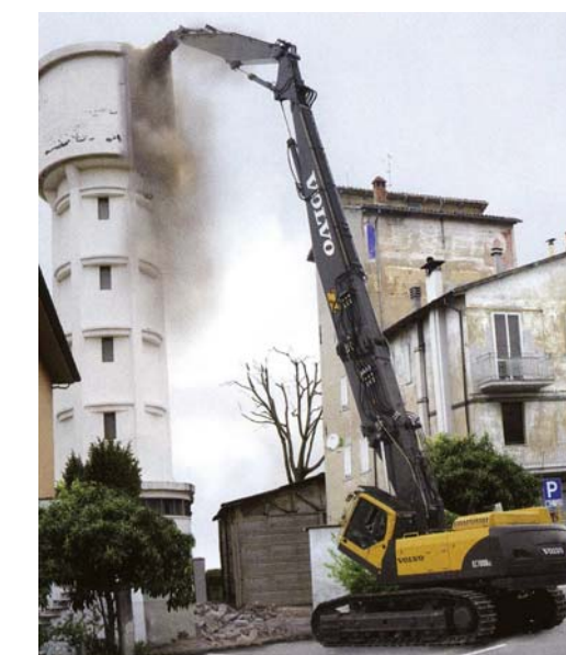
Peso operativo 90 ton, altezza al perno 32m, peso pinza 2500 kg
