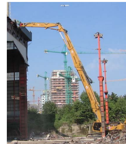
Peso operativo 140 ton, altezza al perno 50m, peso pinza 1300 kg
